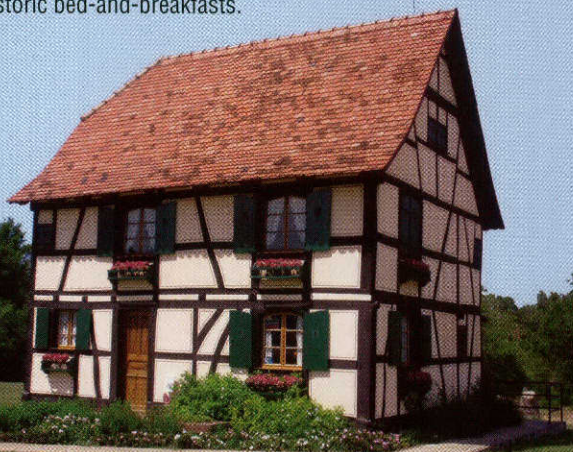
Fachwerk Steinbach House, Castroville
